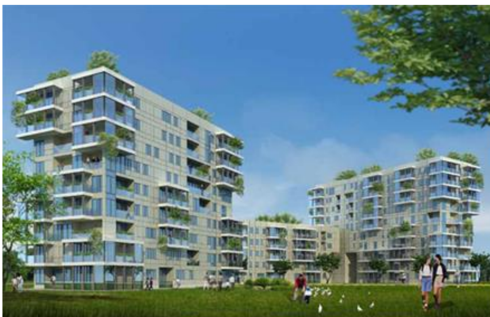
Esempio di chiusura a veranda dei balconi tramite serramenti di tamponatura.
