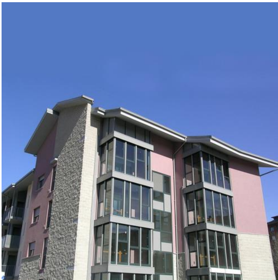
Esempio di chiusura a veranda dei balconi tramite serramenti di tamponatura.
